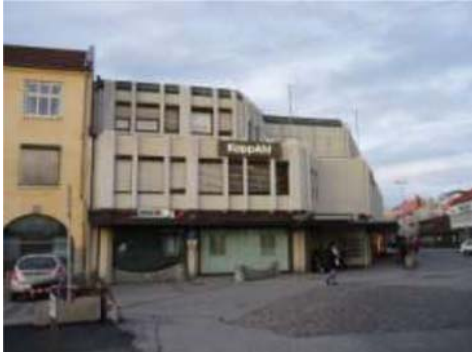
Fasad bild (Fotot tagit i rät vinkel mot fasaden. Hela fasaden syn )
